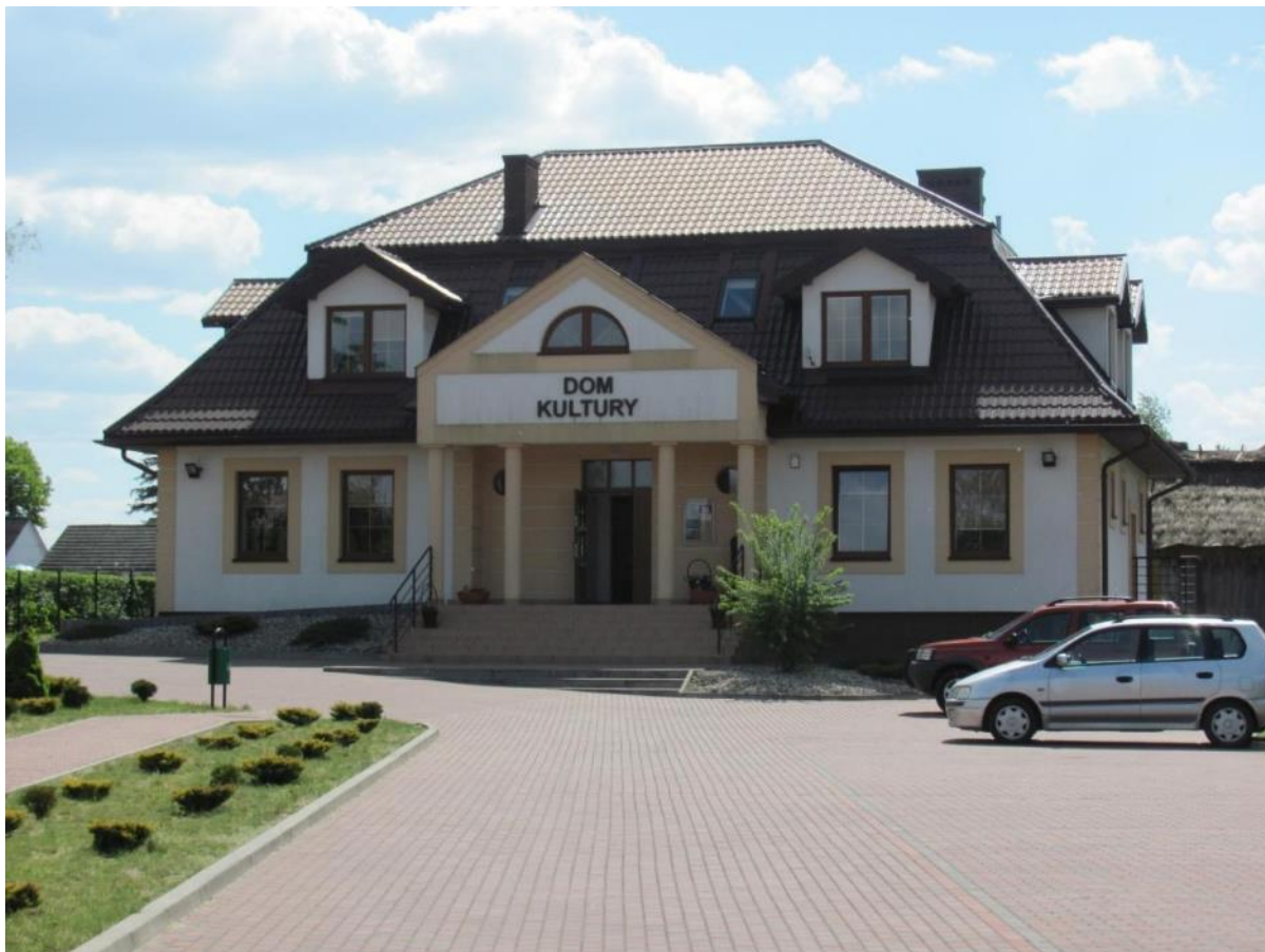
Fot. 32. Budynek Domu Kultury w Siedliszczu
