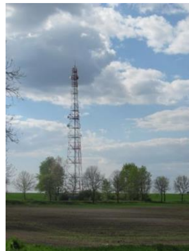
Fot. 9. Wieża przekaźnikowa w Siedliszczu
