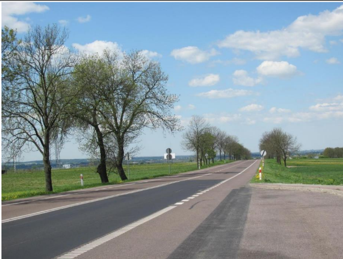
Fot. 33. Droga krajowa nr 12
