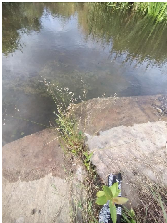
Fot. 1 Widok z pozostałości jazu kozłowego w km 1+890, fot. Kamil Mazur.
