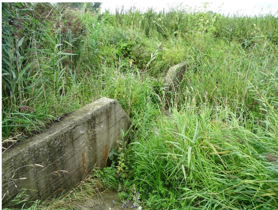
Fot. 9 Obiekt w km 29+150 – koryto ciekę podobnie jak obiekt – całkowicie zdegradowane, brak warunków do rozwoju organizmów wodnych, fot. Maciej Wachecki.
