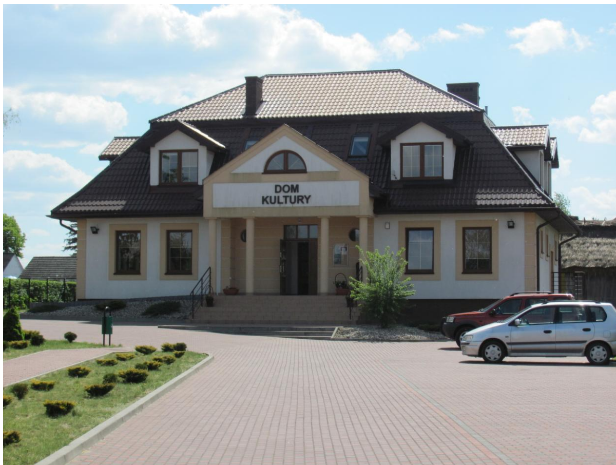
Fot. 32. Budynek Domu Kultury w Siedliszczu
