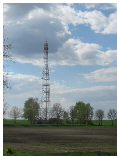
Fot. 9. Wieża przekaźnikowa w Siedliszczu
