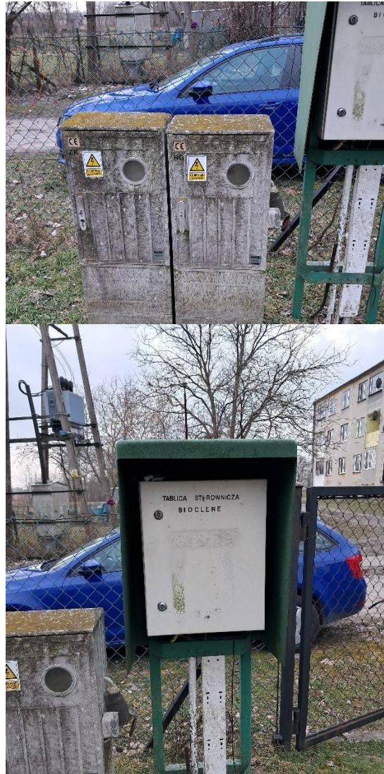
Zdj. 5,6: Szafka sterownicza ze złączem kablowym
